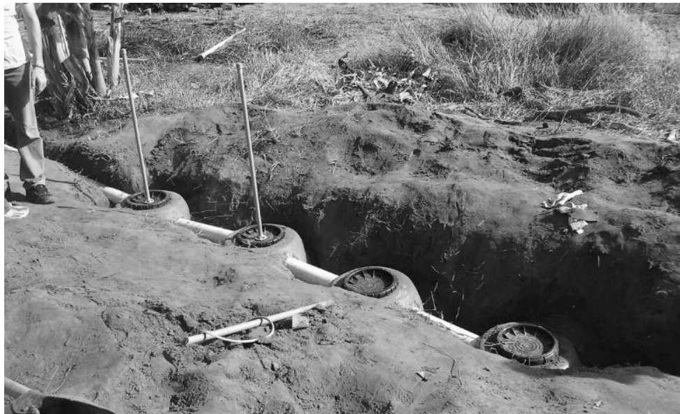
Figura 3 – Implementação da fossa biodigestora por bombonas
