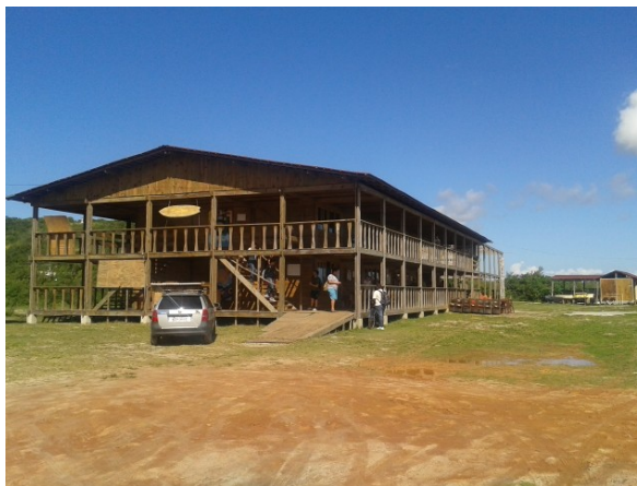
Figura 1: Foto das instalações modulares do IPUFRJ, 2014. Fonte: Imagens próprias.
