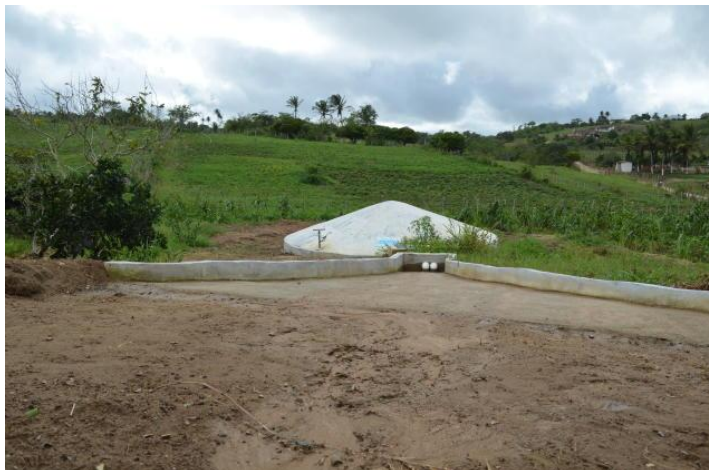
Figura 05 – Cisterna de Enxurrada
