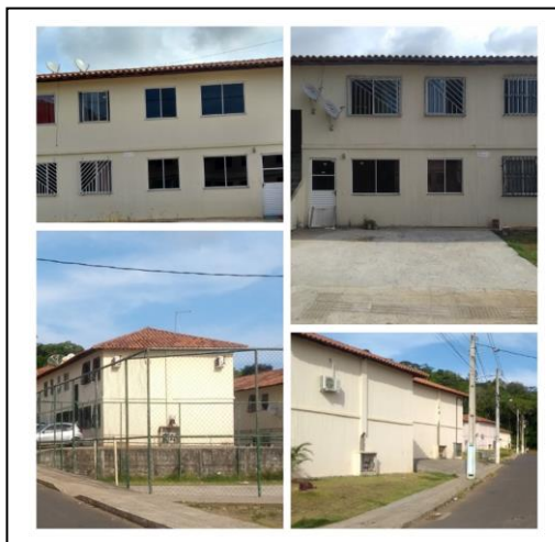
Figura 5. Papel filme em janelas e ar condicionados instalados nos apartamentos do Residencial Rio Cachoeira
