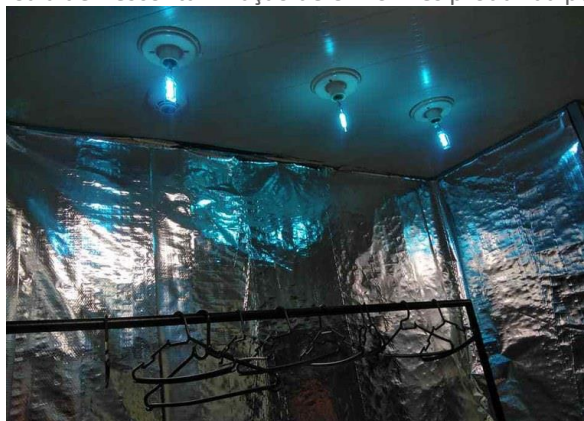
Figura 4 - Sala de Descontaminação de Uniformes produzida pela UTFPR.
