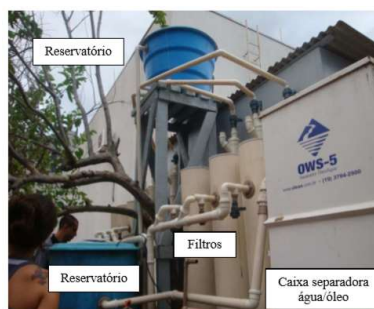
Figura 1. Sistema de remediação gerador do resíduo CCA/CA contaminados com hidrocarbonetos de petróleo
