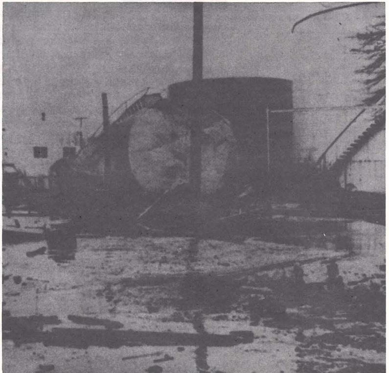
FIGURA 1 — Aspectos do tanque fraturado em Bellview, Nova Jersey, em março de 1973.
