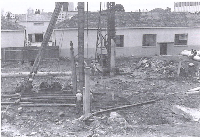
Figura 10 - Obras de Ampliação do CEFET-PR.
