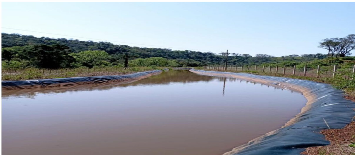
Figura 4 - Canal de adução com revestimento em geotêxtil
