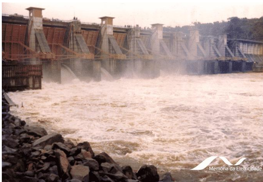
Figura 2 - Usina Hidrelétrica Coaracy Nunes
