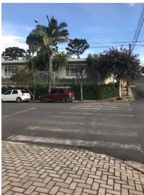
FIGURA 11 – Travessia entre os segmentos de calçada S23 e S26. Falta de manutenção de travessias e inexistência de mecanismos de inclusão aos portadores de deficiências físicas.
