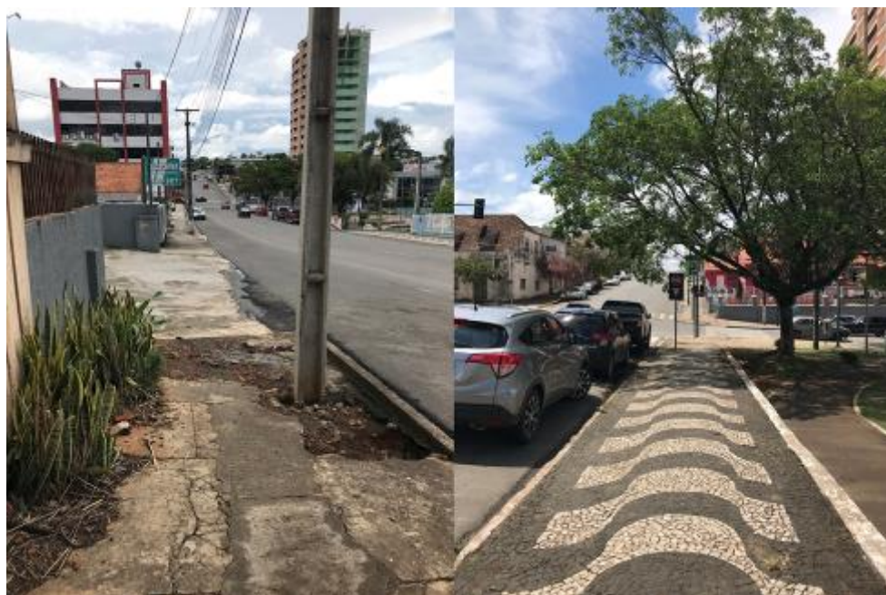
FIGURA 12 – À esquerda, trecho de calçada referente ao segmento S3. À direita, segmento de calçada S4. Ambos pertencentes ao mesmo trecho da Rua Cel. João Pedro Martins.
