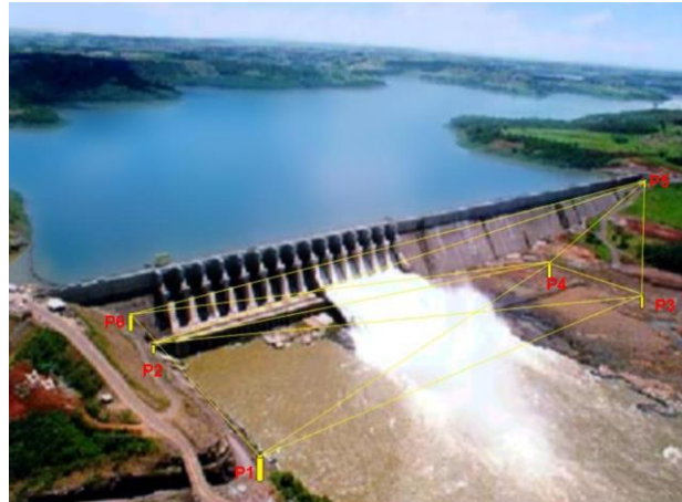
Figura 1 – Rede externa de monitoramento geodésico
