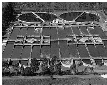
Fig. 1: Estação de tratamento de esgoto Belém
