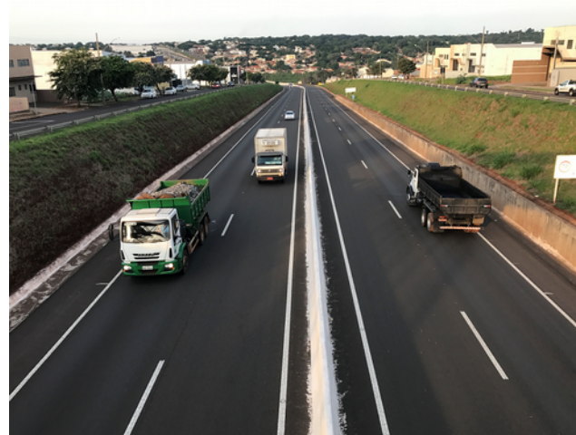
Figura 6 – Trecho do Contorno Norte com pistas rebaixadas em relação ao entorno
