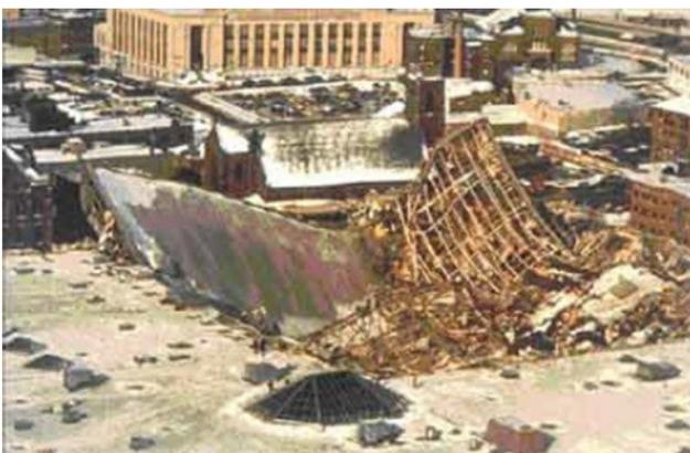
Figura 2 – Colapso do telhado da arena de Hartford. Fonte: Hrinda (2010).
