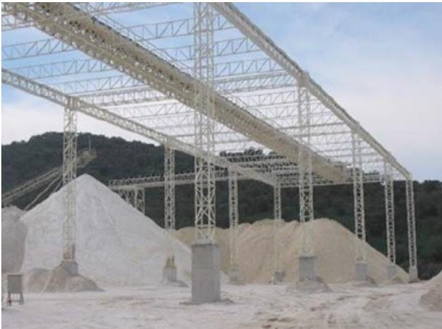
Figura 1 – Sistema estrutural treliçado. Fonte: Seçer (2009).
