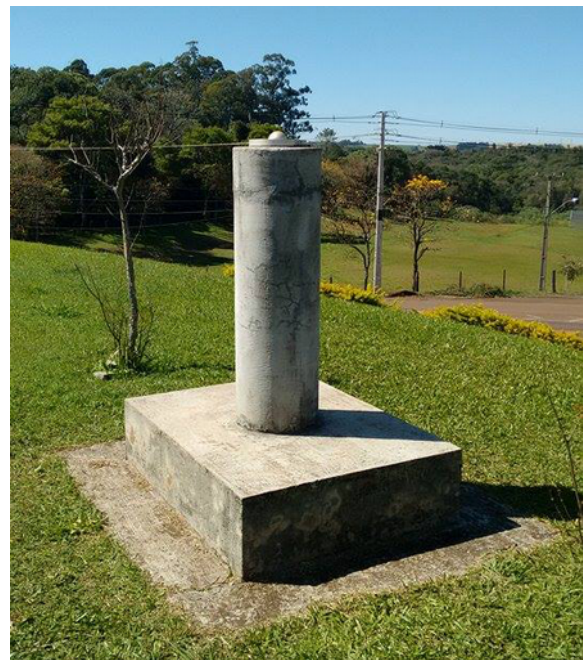
Figura 2 – Pilar de concreto com sistema de centragem forçada. Fonte: Acervo pessoal
