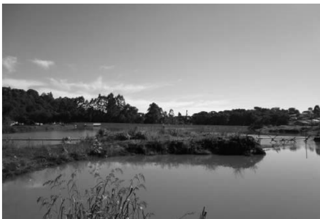
Figura 4: formação do lago, com a construção da barragem.
