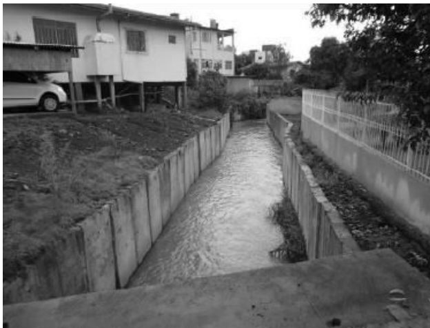
Figura 3: Canalização retangular, pré-moldado.
