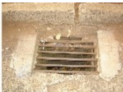
Figura 2: Grelhas das bocas-de-lobo fixadas.
