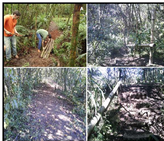
Figura 1. Construções infra estruturais: (A) ponte de passagem, (B) corrimão de apoio, (C) deposição brita, (D) escada.
