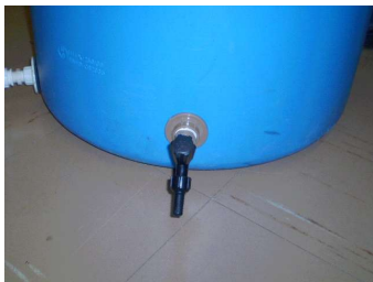
Figura 8: Torneira para retirada da água da cisterna.
